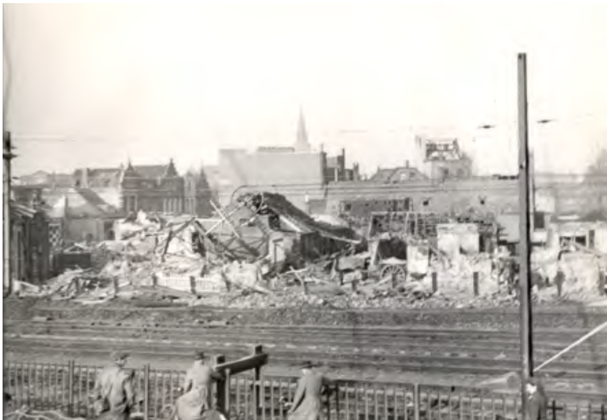
↑ Schade Oude Bogert door bombardement van 6 december 1942 gezien over het spoor vanaf de Parallelweg, 1942-1943. Beeld: RHCE.
